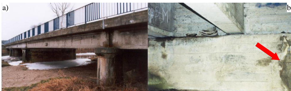
Rys. 1. Most drogowy przez rzekę Mała Panew w miejscowości Staniszcze Małe (źródło: opracowanie własne): a) widok z boku od strony wody dolnej, b) widok od spodu, od strony wody górnej – podparcie belek głównych na zarysowanym przyczółku prawobrzeżnym Fig. 1. Road bridge over Mała Panew river in Staniszcze Małe: a) side view from tail water, b) bottom view from headwater – visible main beam bearing on cracked abutment
