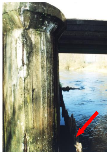
Rys. 5. Widok z boku od strony górnej wody na filar nr 2.
